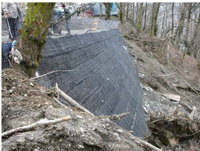
В процессе строительства
