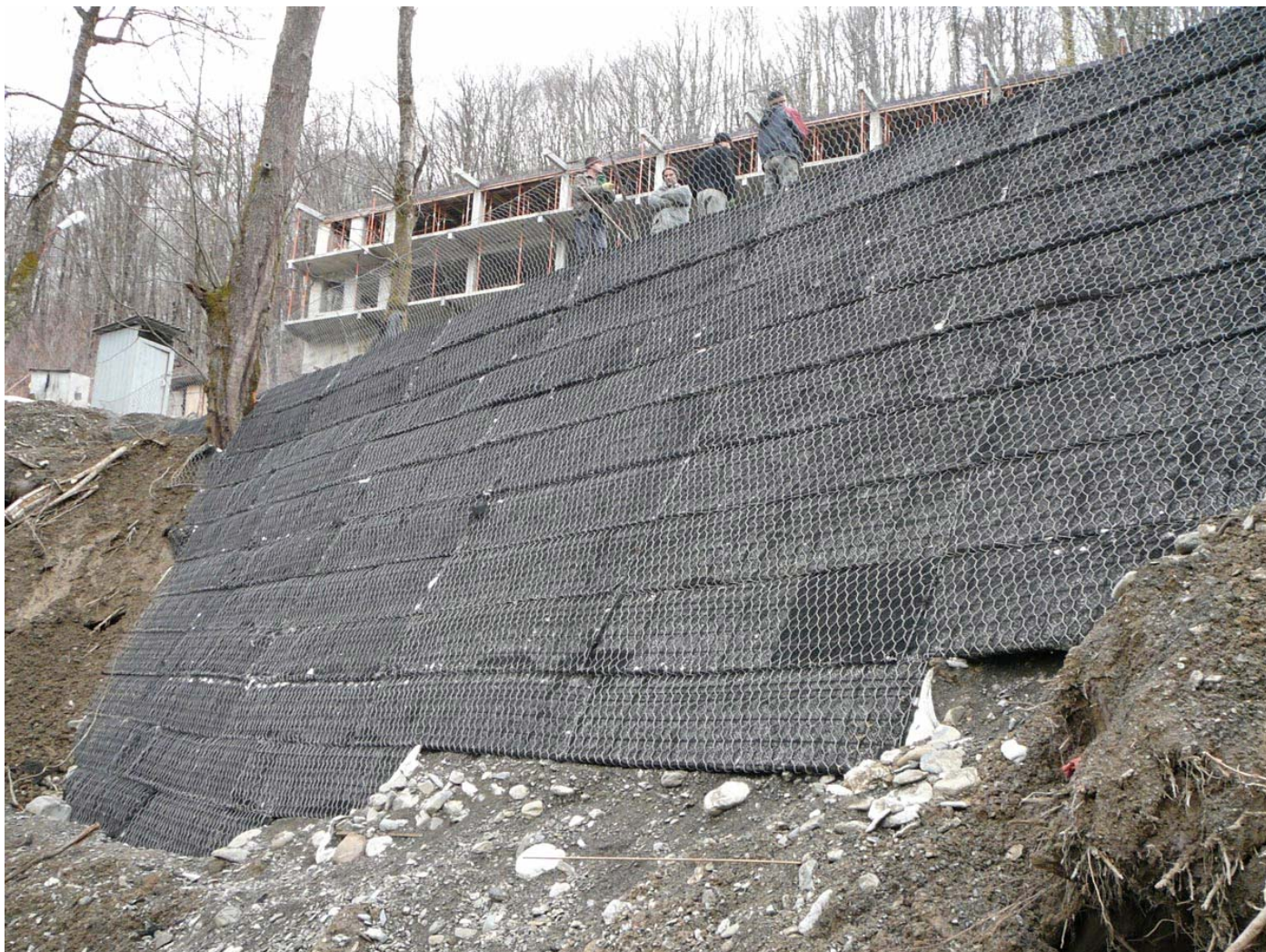
В процессе строительства
