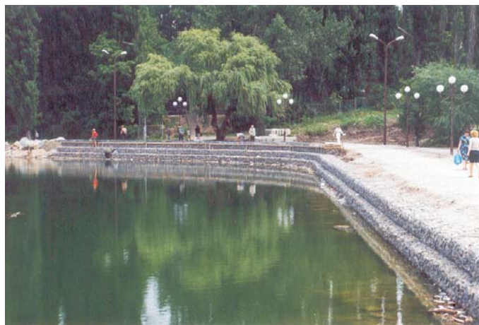
В процессе строительства
