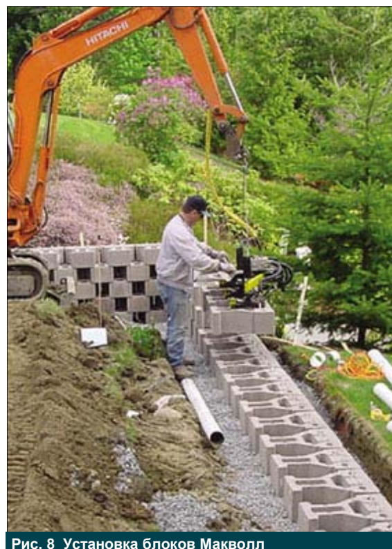
Рис. 8 Установка блоков Макволл
