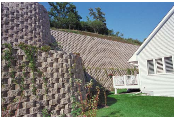
Рис. 1 Армирование склона материалом Макволл
